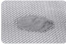
**Paso 2:** Esta mezcla se aplica a metal expandido reforzado
